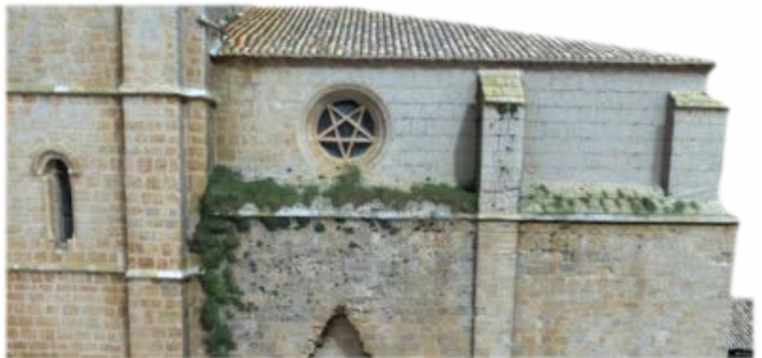
Detalle de fachada oeste
