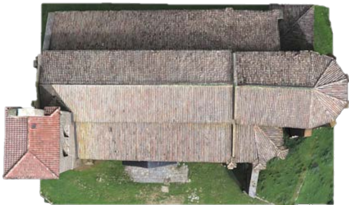
Vista aérea de la planta
