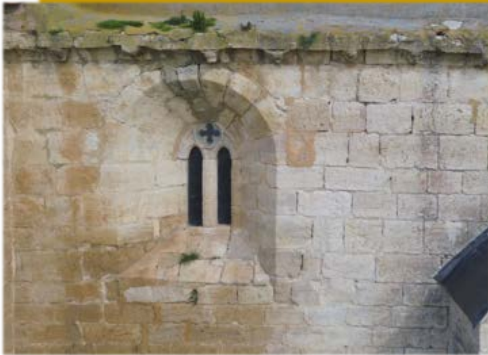
Canecillos y ventana gótica de la fachada meridional
