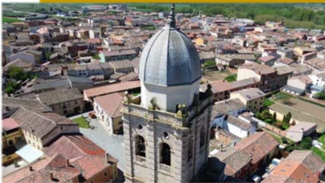
Vista aérea de la torre
