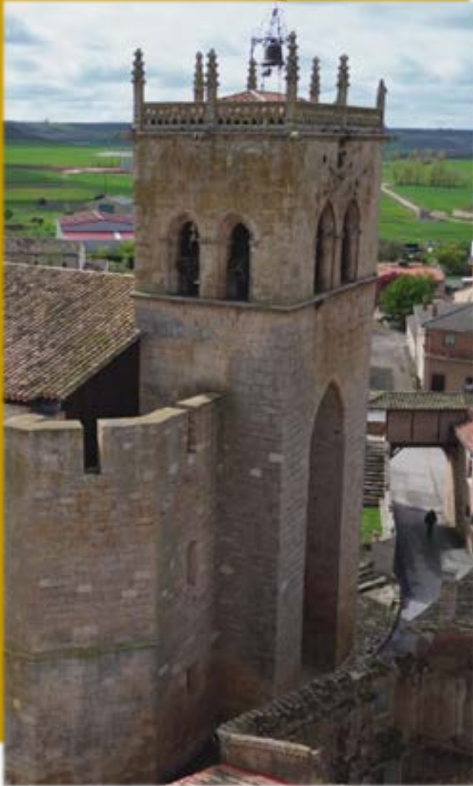
Vista aérea de la torre
